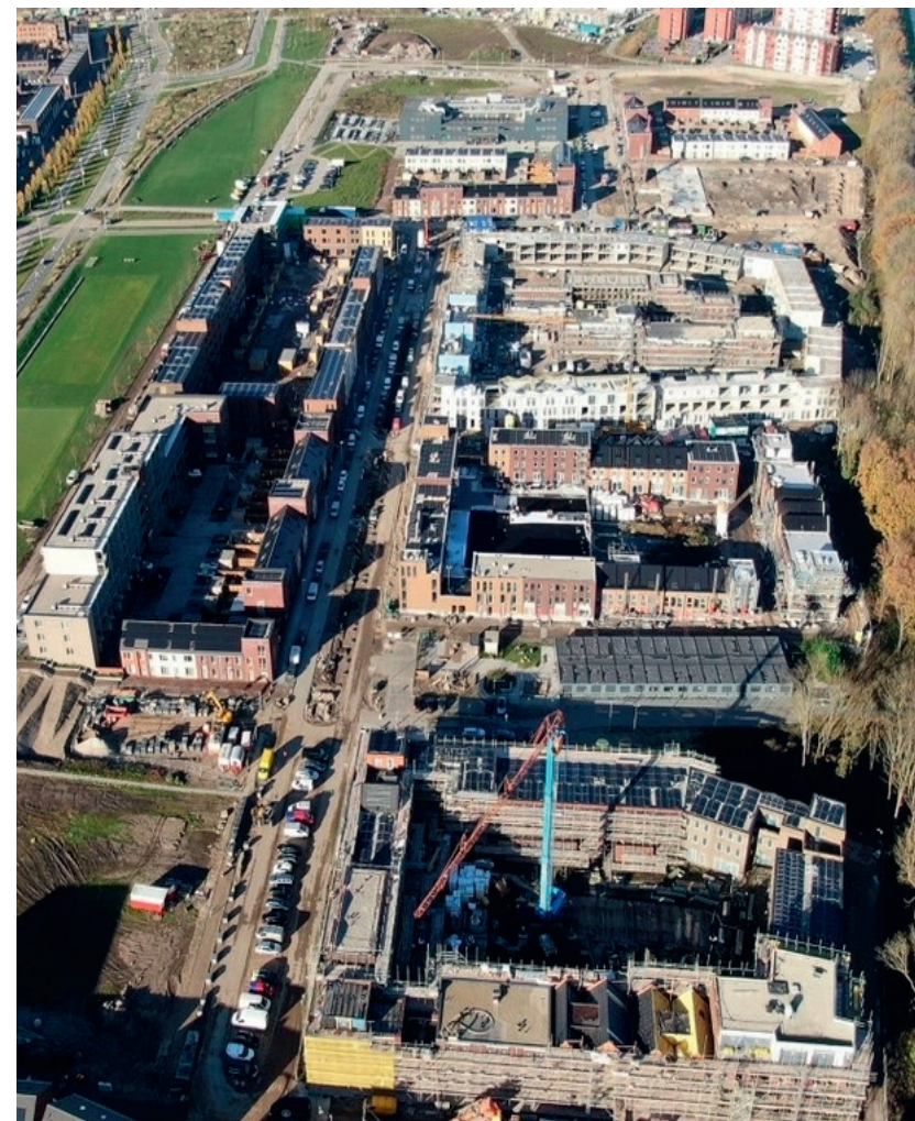
Leeuwesteyn in de bouwfase
